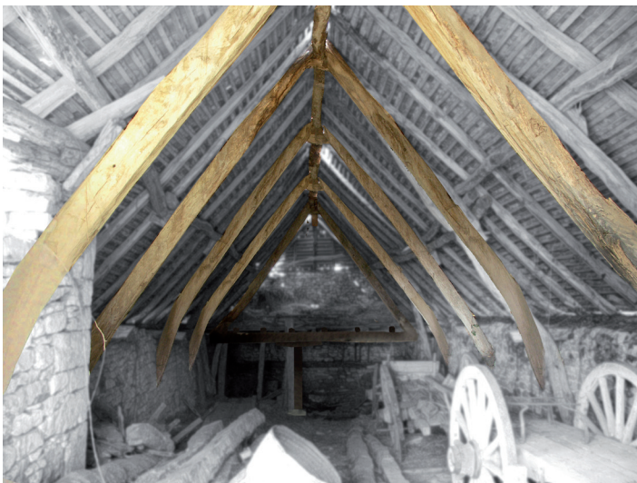
Charpente : hypothèse de restitution des couples d'origine
