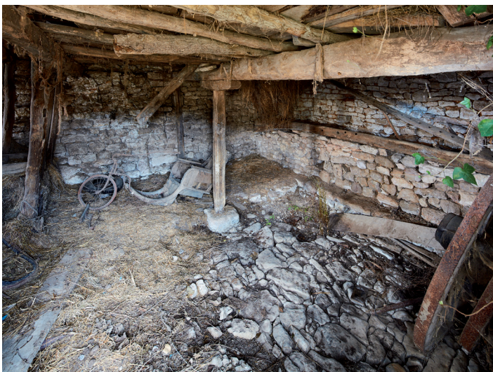
La mageoire sous le fenil soutenu par le poteau chanfreiné
