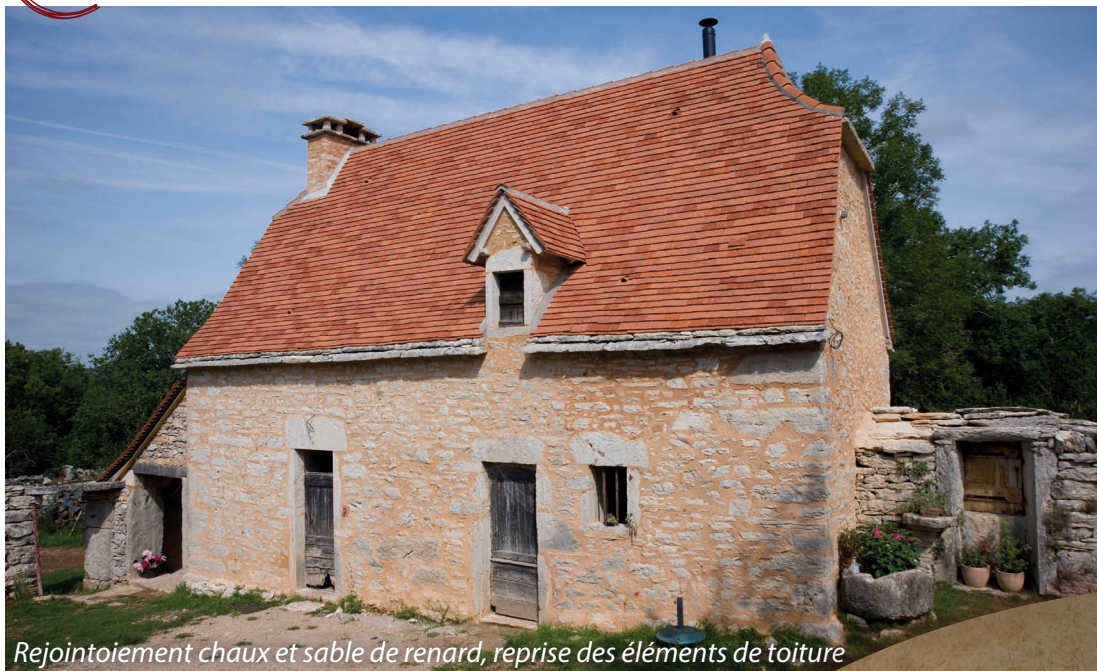
Restitution du fournil et de la toiture du four à pain
