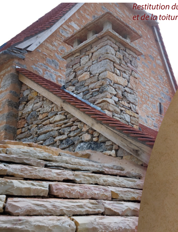
Rejointoiement chaux et sable de renard, reprise des éléments de toiture
